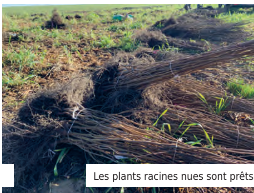
Préforage des fosses de plantation à la tarière.
