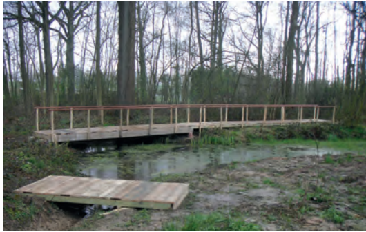
Caillebotis longeant et enjambant la mare du Péry, très beau travail réalisé par nos ouvriers communaux
