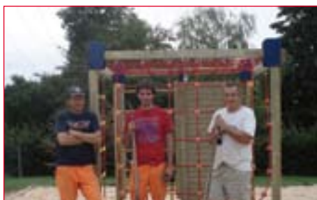
L'équipe des travaux installe de nouveaux modules de jeux extérieurs.
